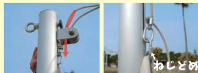
反対側のネットの端にある楕円形の金具を滑車の間に通します
